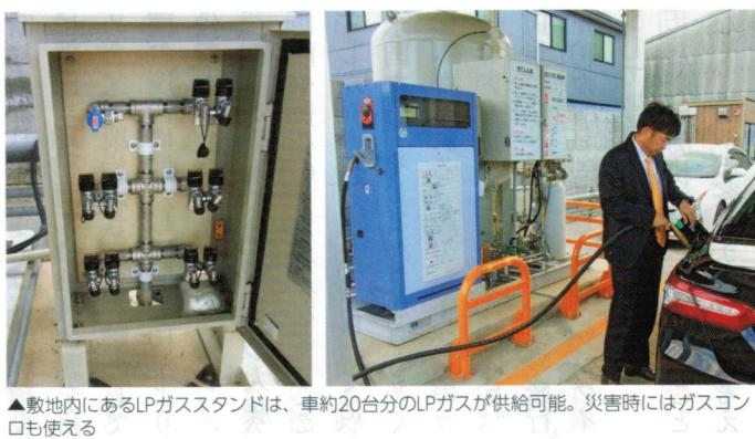
▲敷地内にあるLPガススタンドは、車約20台分のLPガスが供給可能。災害時にはガスコンロも使える
